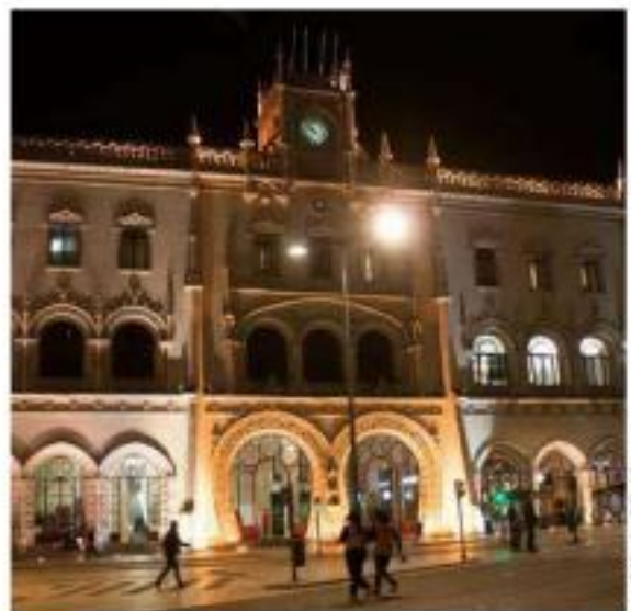
A FERRO DI CAVALLO L'entrata principale della Estação do Rossio, affacciata su Praça Dom Pedro IV.
